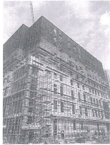
建设中典型照片
