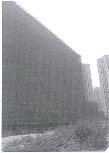
建设中典型照片
